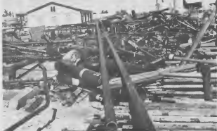
RECIPÉ: TAKE some pipe, add skilled craftsman, mix in engineers and elbow grease. RESULT: Fortbousing Cat Plant project. RECETA: TUMA algun tubo, pone acerca bombernan di ofishi experto, mezcla acerca ingeniero y elbow grease y e RESULTADO TA: E proyectu vendero di Cat Plant.
